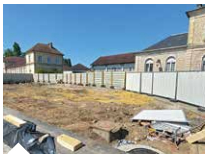
Création d'un bassin d'orage rue Chantepie-Mancier
