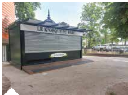
Aménagement de la terrasse du kiosque du Parc Manchez
