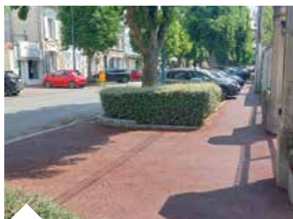
Réfection des trottoirs avenue de Paris
