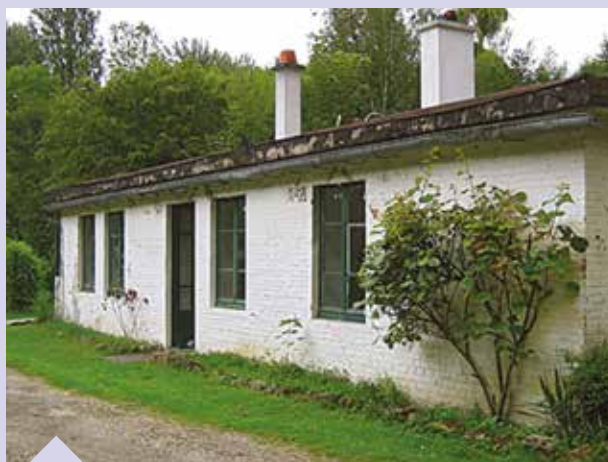
Seul bâtiment subsistant du camp de Cassan. Ils étaient tous sur le même modèle, à l'exception des cheminées rajoutées depuis.
