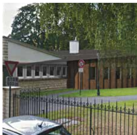
RÉNOVATION DU CCAS ET CRÉATION DU MULTI-ACCUEIL 750 000€
